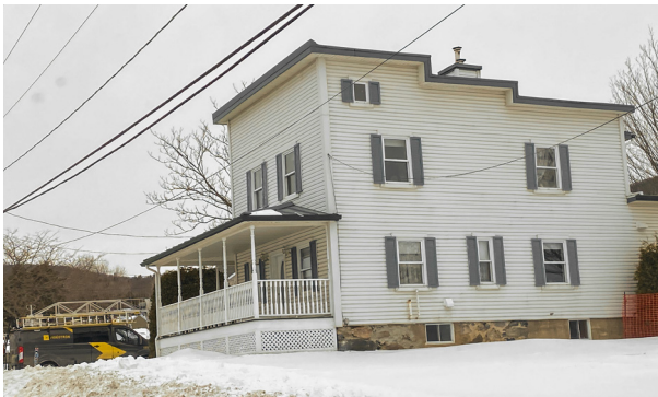
Fig. 7 — Maison boomtown caractérisée par sa volumétrie simple couronnée d'un toit plat ou à faible pente
